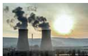
Градирни на электростанциях
