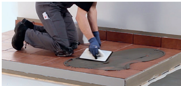
Затирка швов с ASO-Flexfuge.
