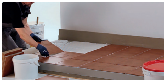
Укладка плитки в клеевую постель комбинированным способом с нанесением клея и на основание, и на плитку.
