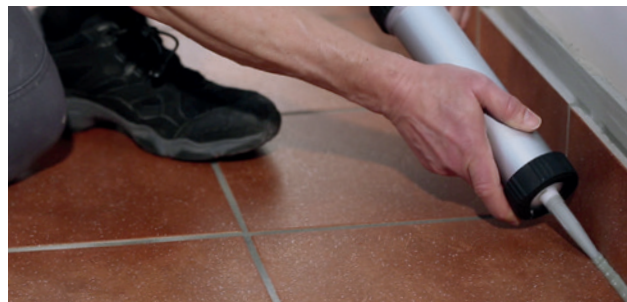
Герметизация компенсационных швов с соответствующим шнуром круглого сечения и ESCOSIL-2000.
